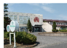
現在の館林市サイクリングターミナル
